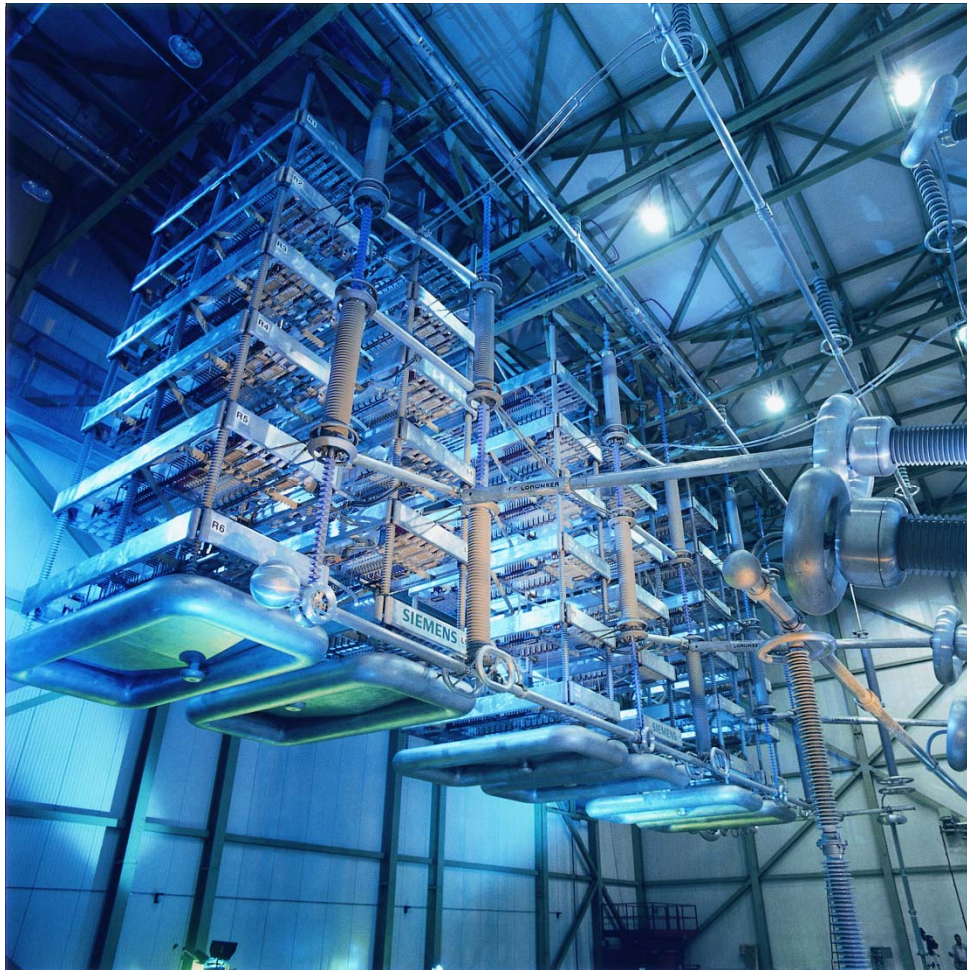
Bild 2.38 Aufbau der Ventilhalle für eine 12-pulsige Stromrichtergruppe
